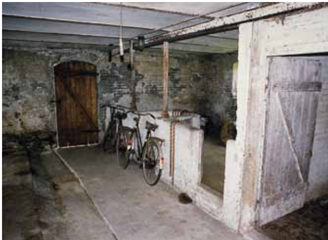
"Baderum" før påbegyndelse af renovering.
